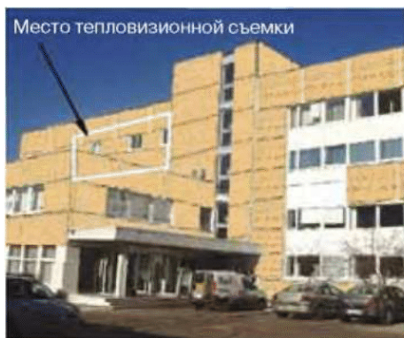
Фасад до утепления
