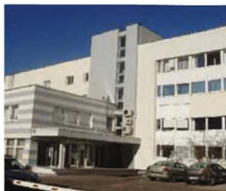
Фасад после утепления
