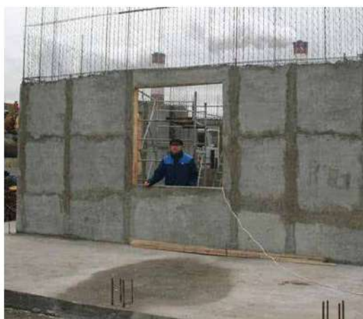
Возведение офисного помещения с применением БИРСС Термопор Монолит
