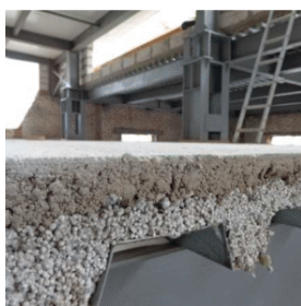
Облегченные стяжки и перекрытия
