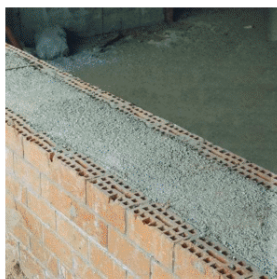
Теплоизоляционное заполнение полых стен
