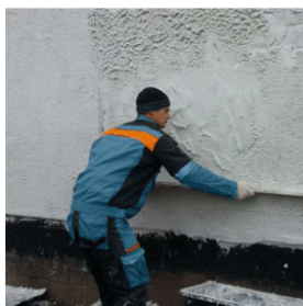
Бескаркасное и бесплитное утепление фасадов
